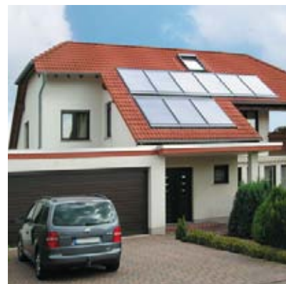
Capteurs solaires WTS-F1 en intégration de toiture
