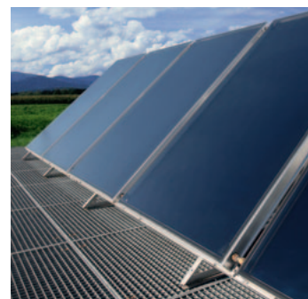
Na dachu płaskim
