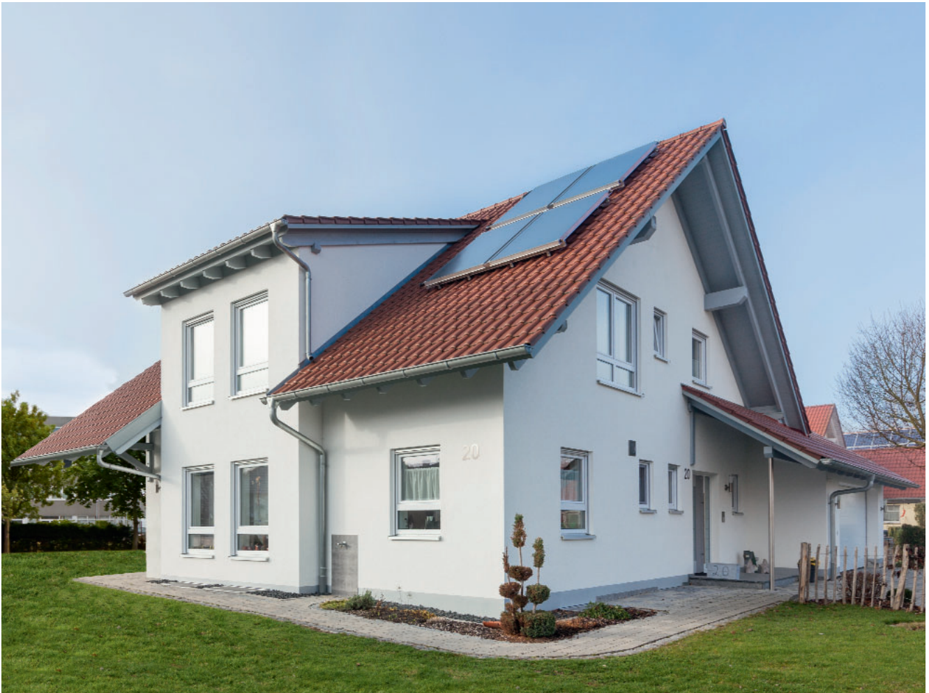
Sistem sprejemnikov sončne energije za kombinirano pripravo sanitarne tople vode in podporo ogrevanju prostorov
