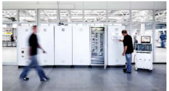
Produktion bei Neuberger Gebäudeautomation: Auch der Bau von Schaltschränken gehört zu den Aufgaben der Firma.
