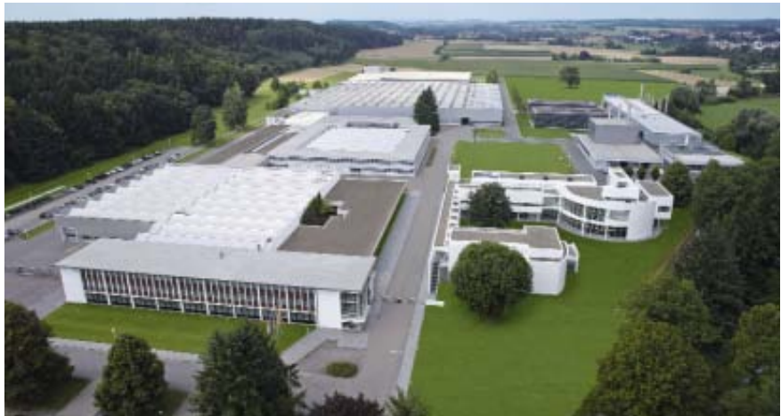
Überblick: das Werk Schwendi mit den Verwaltungsgebäuden vorn links, gegenüber das Weishaupt Forum, rechts dahinter die Heizzentrale mit Forschung und Entwicklung, im Zentrum die Fertigung mit den Montage- und Lagerhallen.
