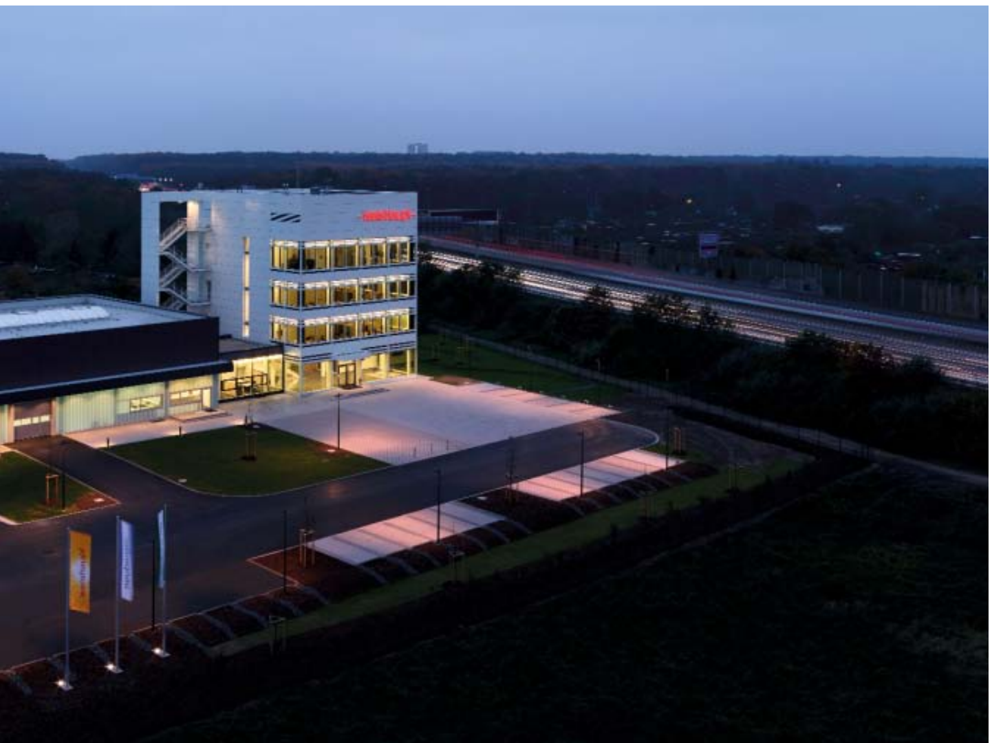
Weithin sichtbar: Die Niederlassung Frankfurt, direkt an einer der meistbefahrenen Autobahnen Deutschlands, der A5. Entworfen vom Münchner Architekten Wolfram Wöhr.
