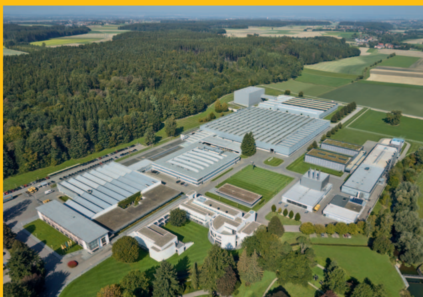
Siedziba firmy i fabryka w Schwendi
