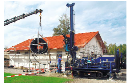
Perforación para geotermia con BauGrund Süd
