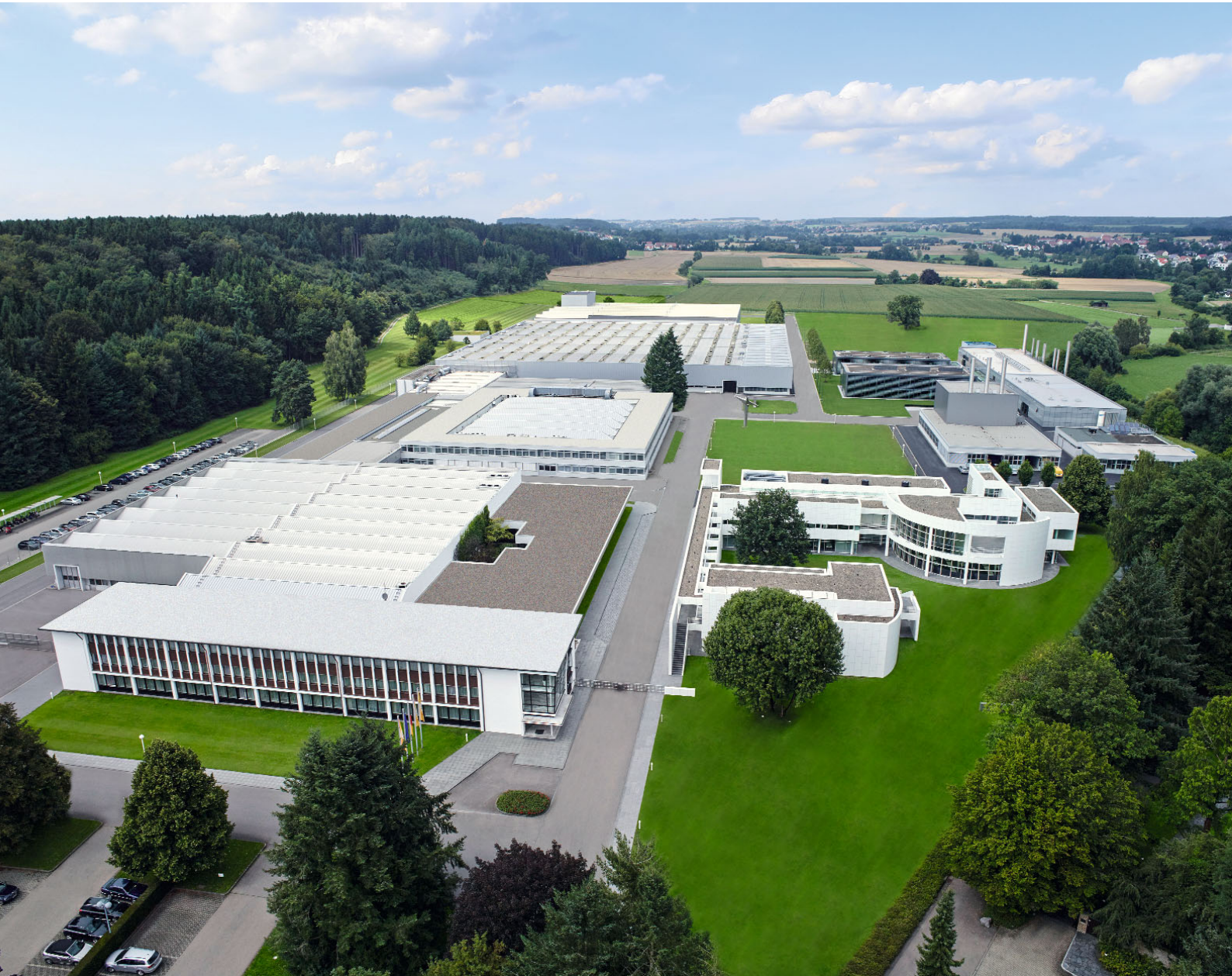
Administração, produção de queimadores, montagem dos painéis de comando e Departamento de Pesquisa na matriz em Schwendi
