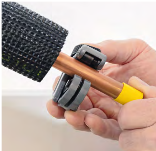
1. Raccourcir la conduite
